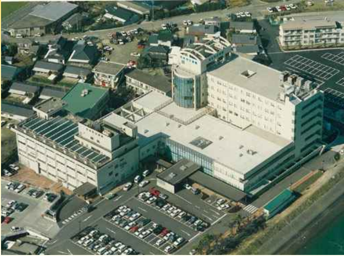
平成6年頃 出水総合医療センター航空写真
