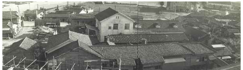
昭和41年頃 解体前の出水市立病院
