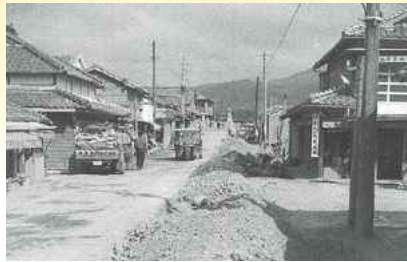
昭和32年 国道3号の道路舗装工事（早馬地区床掘）
