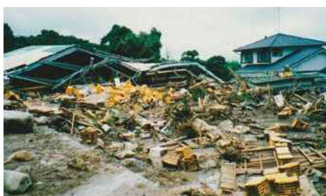
平成9年7月 針原川土石流災害の被災現場
