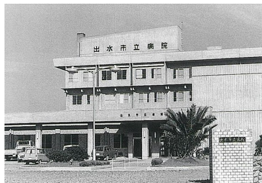
昭和41年9月20日、市立病院が完成 (改築)
